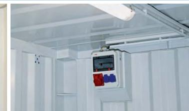
Rampe néon et tableau de distribution avec prises électriques
